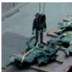
Utzon-Franks Apollon-gruppe under nedtagningen i forbindelse med ombygning og renovering.
