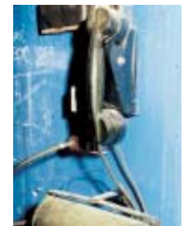
Fotos fra ældre - nu forsvundne - installationer på Stærekassen.
